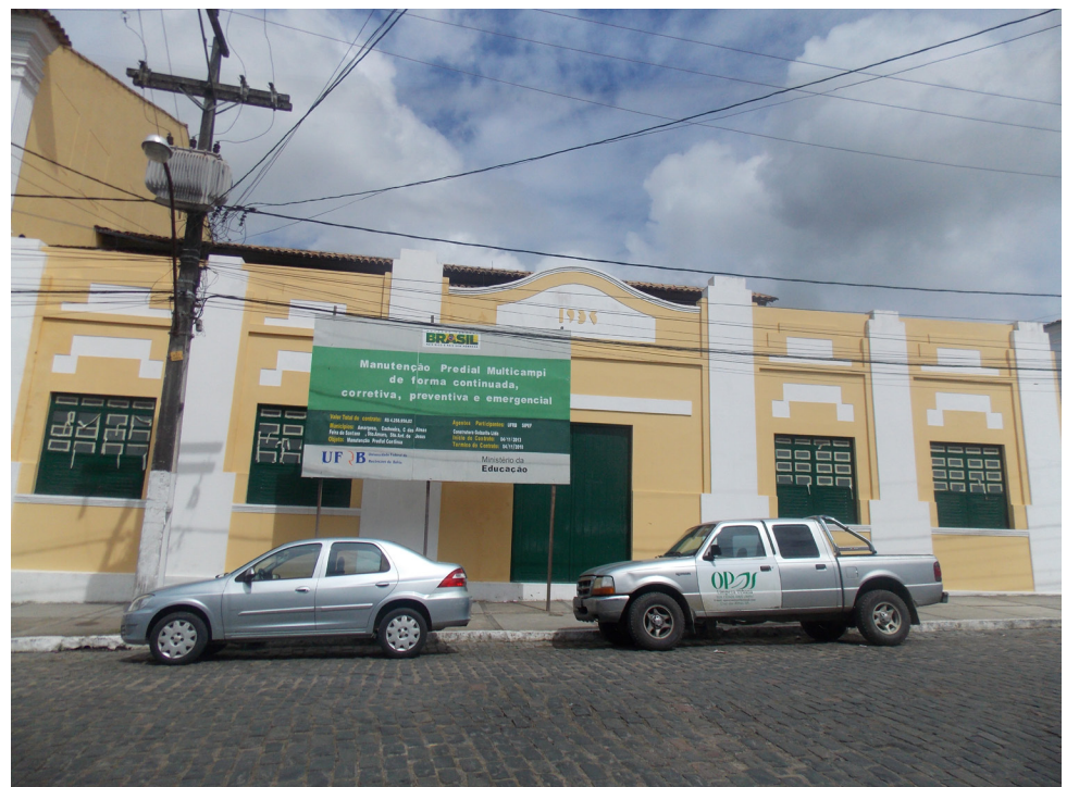
Mesmo com a fachada recém pintada, o CAHL é um dos centros que mais sofre com problemas estruturais.
