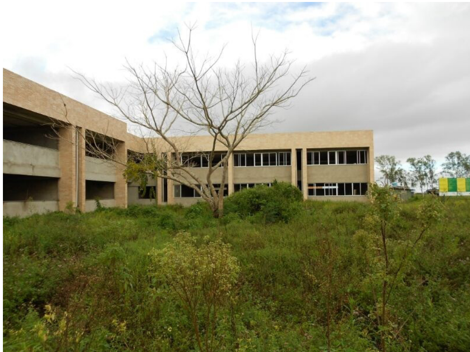
Mesmo em obras mais adiantadas, o CCS convive com o abandono.
